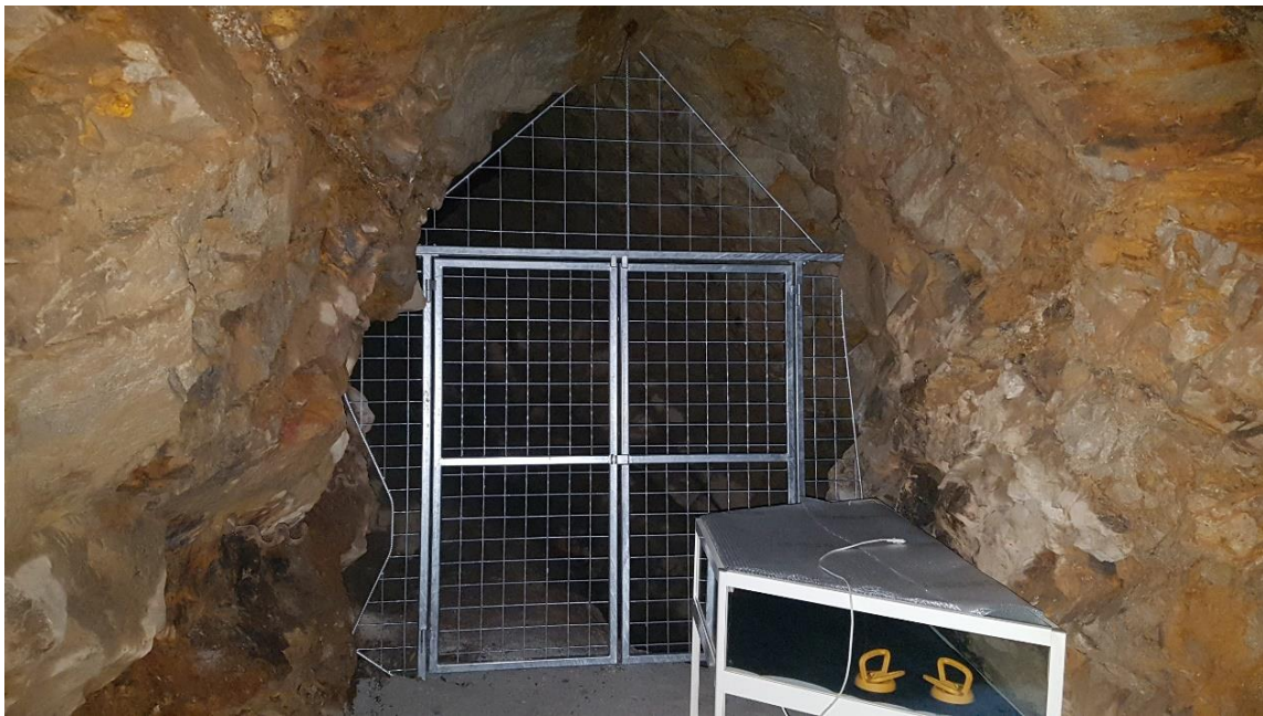
Slika 2.10 – Objekt 9 – Ograja z dvokrilnimi vrati pred vstopom v vpadnik 9
