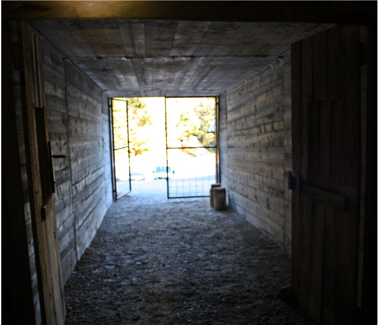
Slika 2.2 – Portal – pogled iz jame
