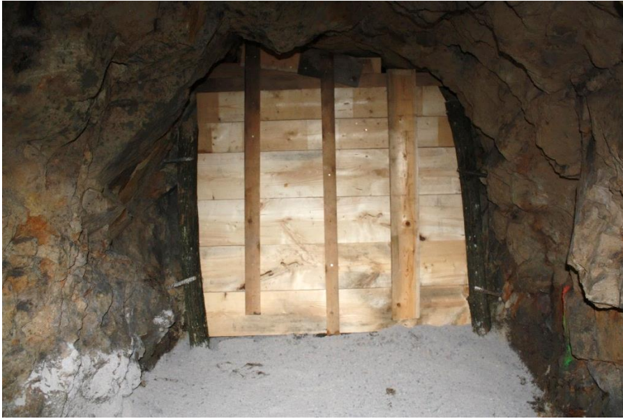
Slika 2.3 – Lesena zadelka pri jašku-sipki v objektu 6c
