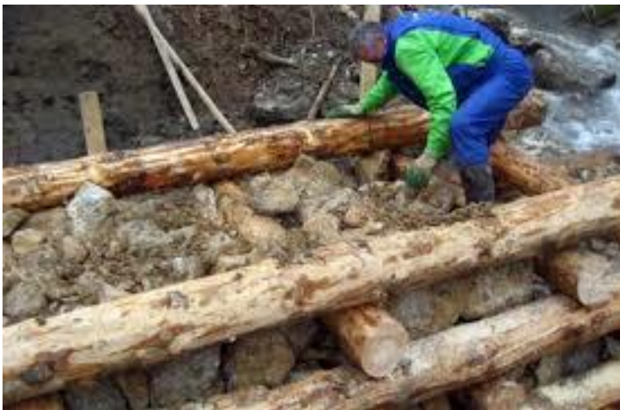
Slika 3.1 – Prikaz izvedbe kranjske stene
